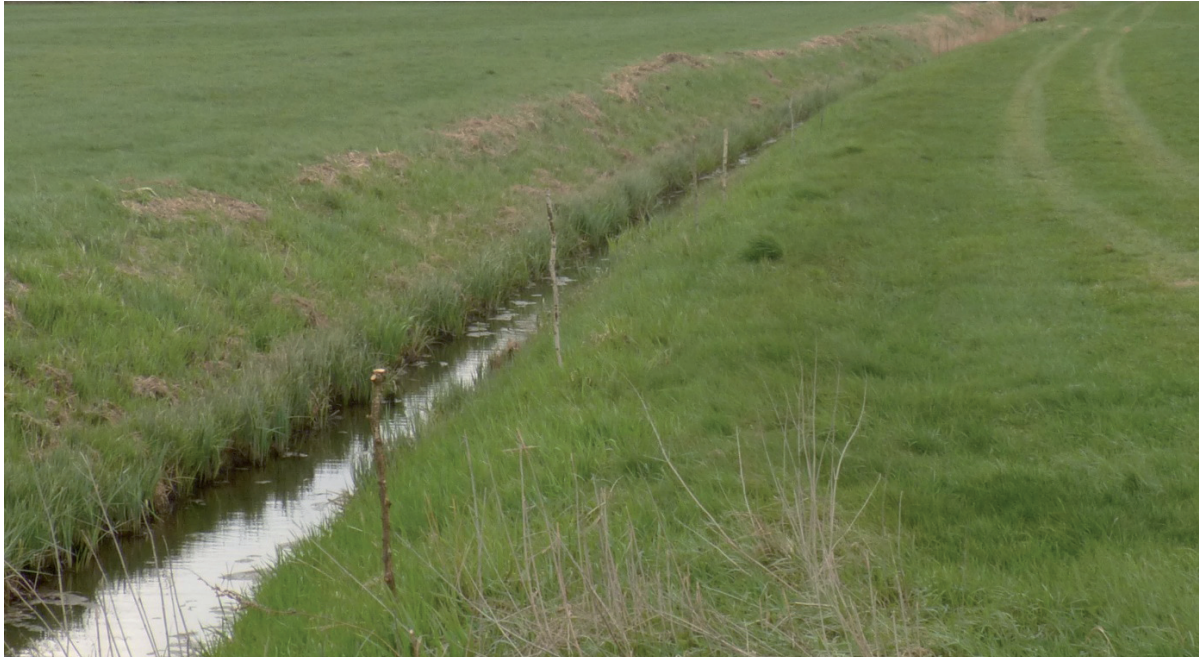
Abb. 3: Zaunanlage an einem Graben. - Soft fence on a drainage ditch (Photo: © O. OLEJNIK).
